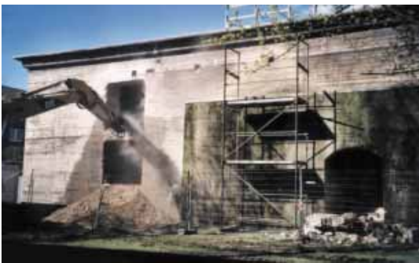
Der im Umbau befindliche Bunker „Alte Heid“
