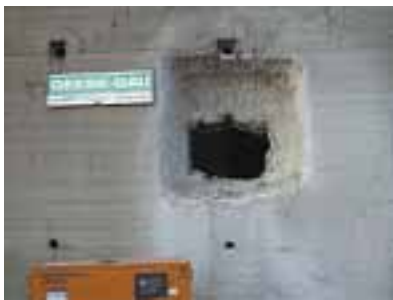
Der erste Fenster-ausschnitt wird gefräst – Wandstärke: 1,10 m
