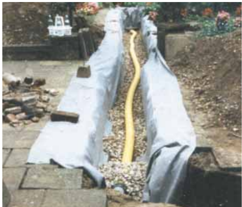
Einbau einer Rigole im privaten Garten
